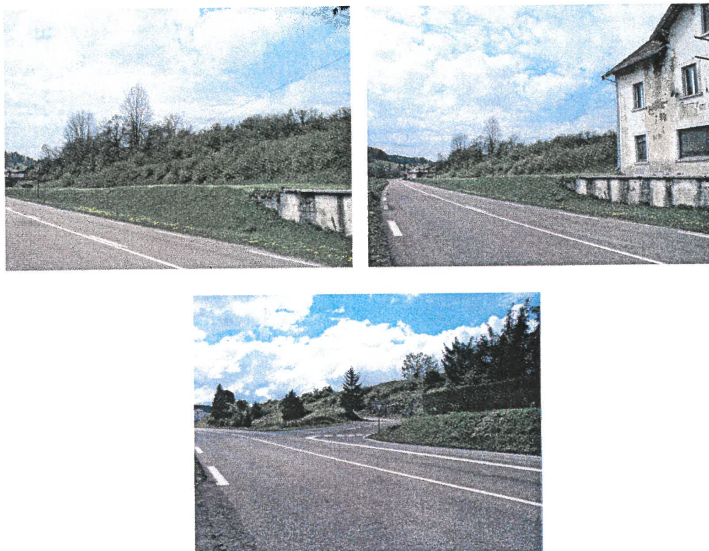
Le site vu de la RN5 en provenance de Champagnole en direction de Saint Laurent-en-Grandvaux : espace boisé du talus moins dense, des essences de taille limitée.
