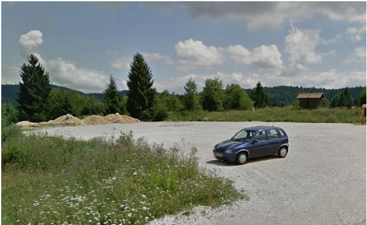
Prise de vue n°2 avant travaux (par Google Earth)
