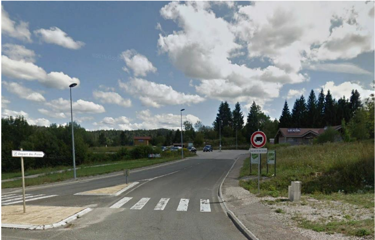
Prise de vue n°1 avant travaux (par Google Earth)
